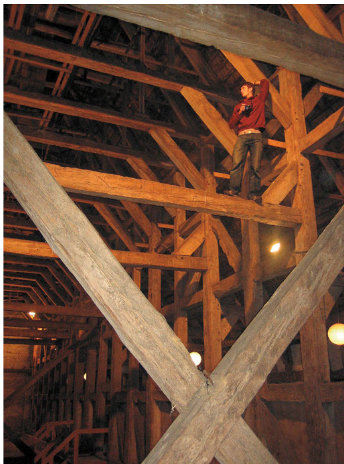
FIGUR 15. Logen på Lundegård på Fyn i Danmark, byggd 1636, är ett exempel på en fullständigt bevarad körloge. Här framgår de många snedsträvorna och de på högremsväggarna liggande bindbjälkarna som takstolens sparrar är tappade i. Foto Ulrich Lange.
