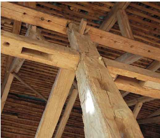
FIGUR 13. Stolpe i östra högremsväggen med remstycke och löshultar, samt stickbjälke. Här ser man hålen efter trägallret som har använts för lagring av sädesskärvar. Här finns snedhuggna tapphål, som ger indikation av återanvändning av timmer, eftersom det inte finns motsvarande tapphål på stolpen. Man ser också att kilarna i stickbjälkens genomgående tapp har överbelastats av dragkrafter, knäckts och därvid förlorat en del av sin funktion. Foto Ulrik Hjort Lassen.
